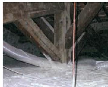
Mousse de polyuréthane injectée en sous-face d'un vide sanitaire:
