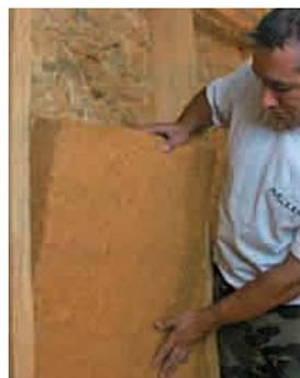
Exemple de mise en œuvre de panneaux de fibre de bois.
