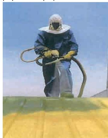
Mousse de polyuréthane injectée dans des combles:
